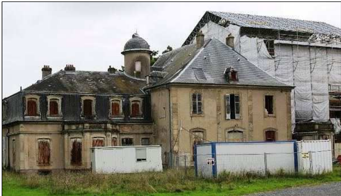
Le Château de La Favorite à Lunéville, en octobre 2013. Des échafaudages laissent penser à des travaux de restauration (Crédits photo : Pymouss, Wikipédia)
