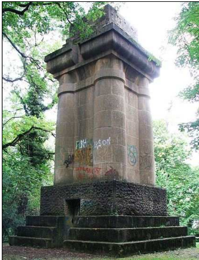
La Tour Bismarck située sur le Mont Saint-Quentin est en péril (Crédits photo : Wikipédia)
